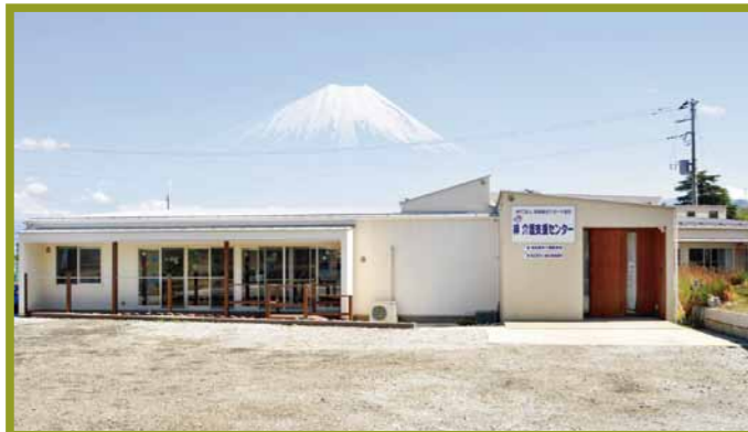
通所・居宅介護施設「絆・介護支援センター」
